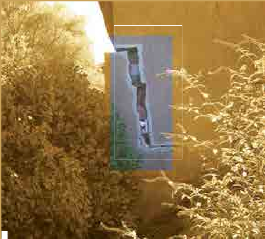
Fissure provoquée par affaissement de terrain
