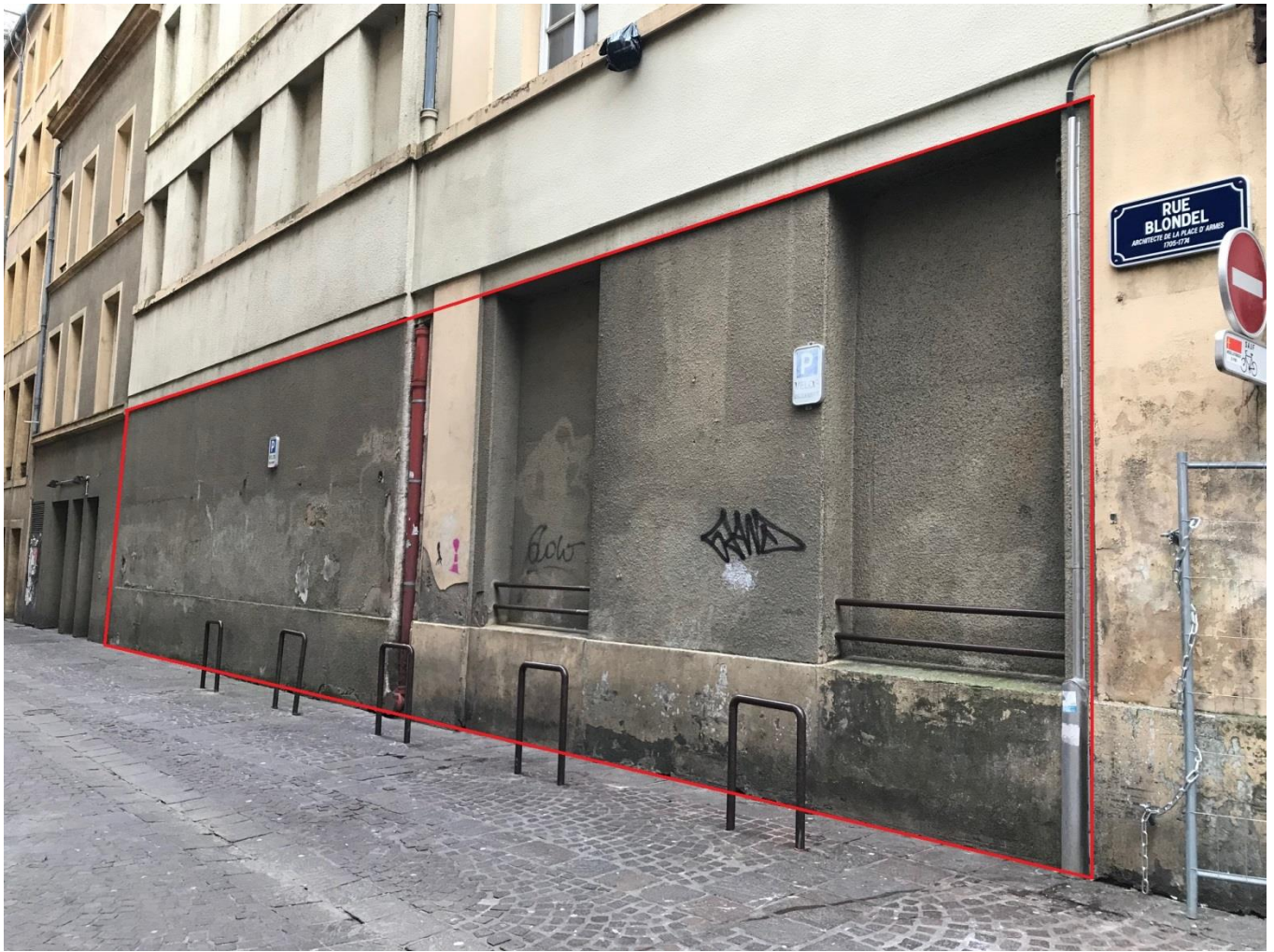
Photographie - Façade arrière, rue J.-F. Blondel 1
