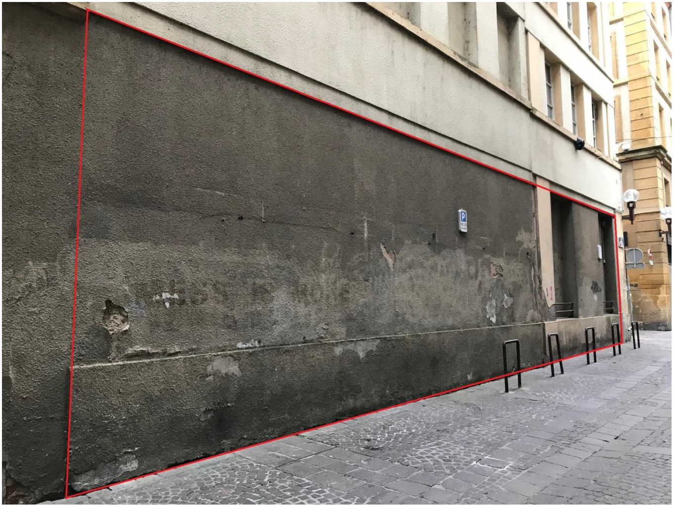
Photographie - Façade arrière, rue J.-F. Blondel 2
