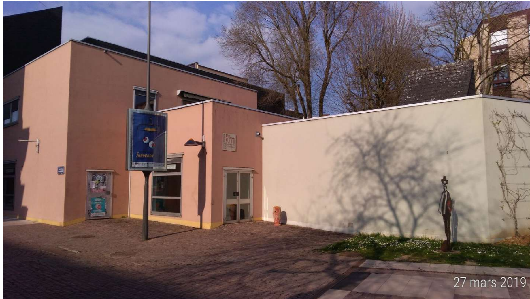
VUE 2 DEPUIS L'OUEST
