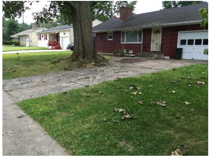
Figure 10 : dégâts causés par les racines, photo Famartin, Wikimedia commons
