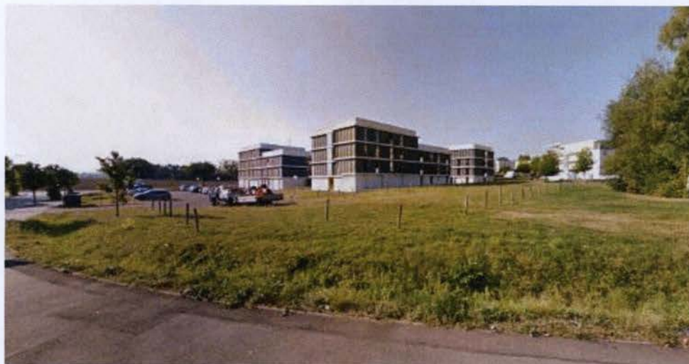
Vue du site depuis rue de Verclay
