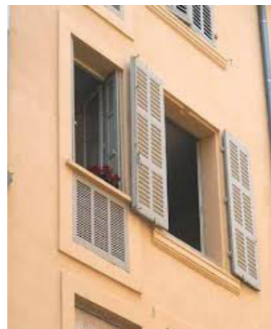
Intégration d'une ventilation en façade
