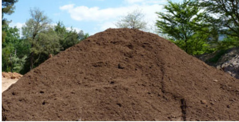
Terre végétale posée en andains de faible hauteur
