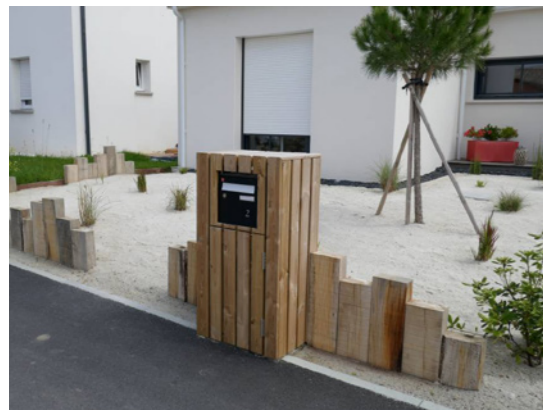
Intégration de coffrets électrique
