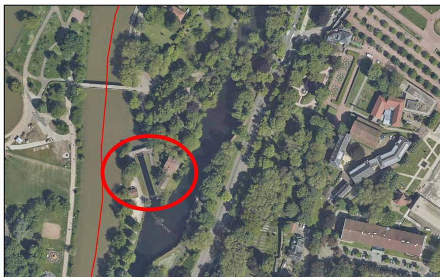
Figure 18 : vue aérienne sur la maison de l'éclusier, l'écluse et l'annexe en entrée de site
