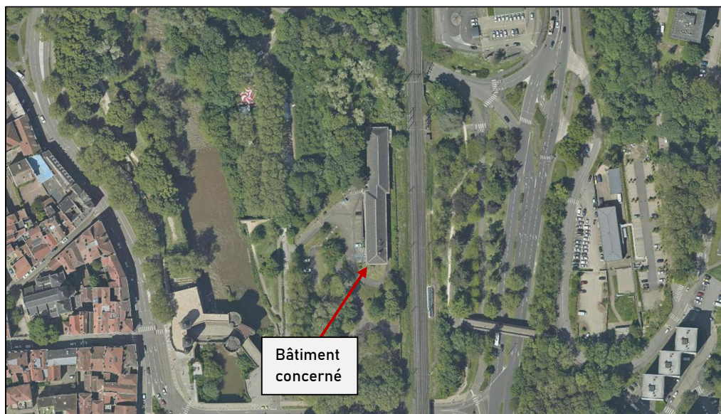
Figure 10 : vue aérienne du bâtiment concerné.
