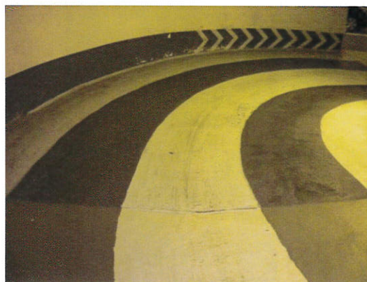
REPRISE SOL RAMPE N-2 VERS N-3
