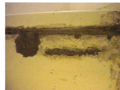
Etanchéité cage d'escalier par injection de résine
