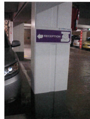
Mise en peinture des poteaux
