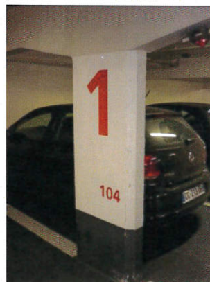
REMISE EN PEINTURE DES POTEAUX
