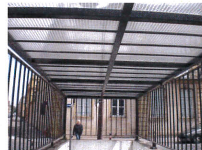
Etanchéité cage d'escalier par mise en place d'un auvent
