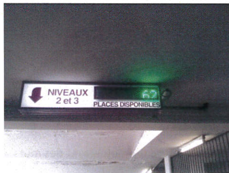
Caisson lumineux à chaque niveau
