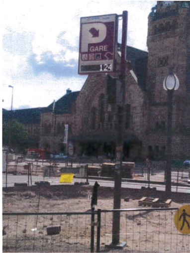
Caisson lumineux extérieur
