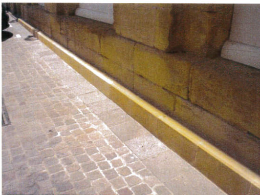
REPRISE PLINTHE PLACE DU MARCHÉ COUVERT TRAVAUXCOMPTE GER 2012
