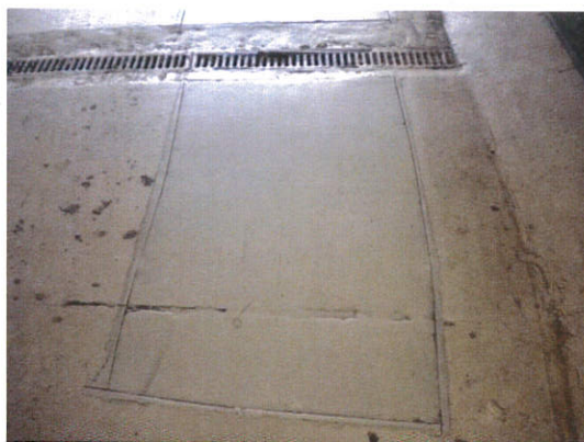
REPRISE SOL RAMPE SORTIE
