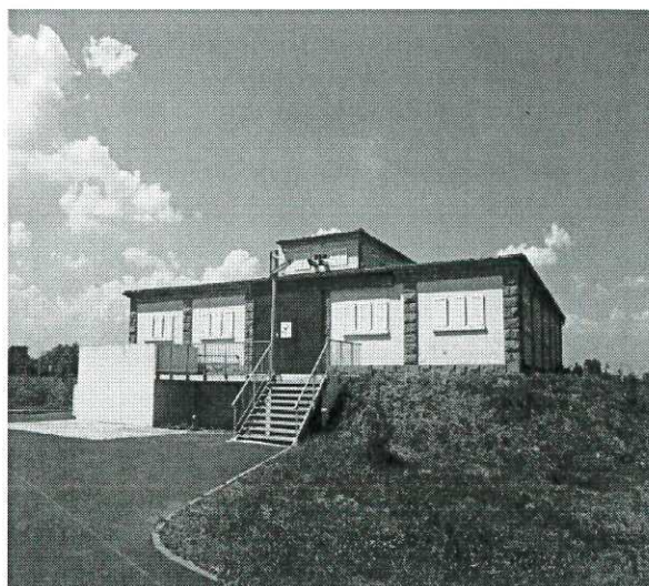
Pomperie de Hauconcourt
