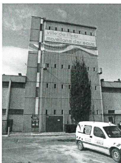
Usine de traitement de Moulins les Metz
