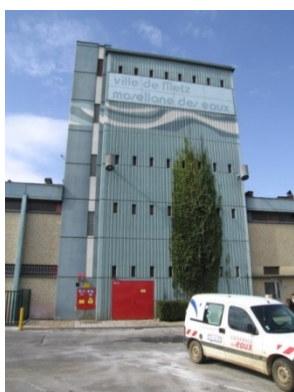
Usine de traitement de Moulins les Metz
