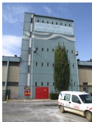
Usine de traitement de Moulins les Metz
