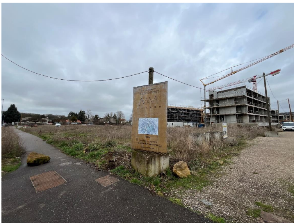
Photographie du terrain à fin 2025 attestant de l'absence de démarrage des travaux
